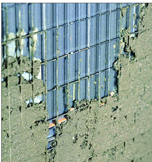
Il controtelaio è una struttura metallica che, integrata a materiali inerti, va a formare un'unica parete. Poiché tale struttura è soggetta a vibrazioni, per evitare l'insorgere di fessurazioni/deformazioni, la preparazione dell'intonaco deve essere eseguita a regola d'arte rispettando scrupolosamente tutte le seguenti istruzioni:
